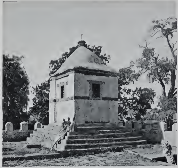
Abb. 49. Dach aus hydraulischem Kalk. Aksum.
